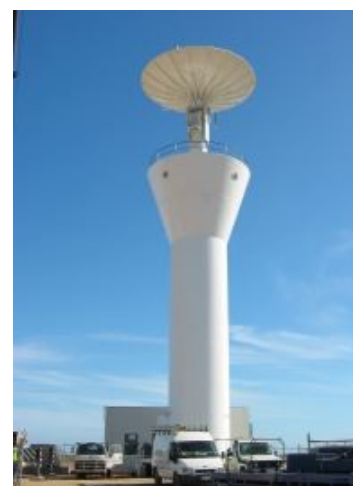
Figure 15 : Le radar météorologique Meteor 1500 d'Adelaïde (Australie) sans son radôme protecteur.
